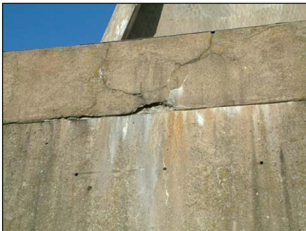
185. Fissures et saletés dans la paroi extérieure en béton.
