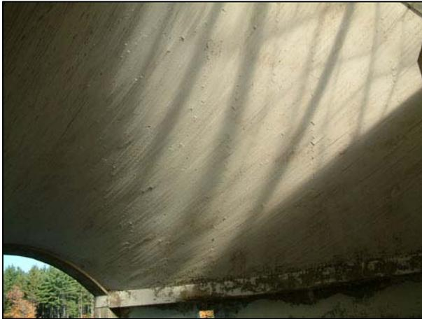
64. Paroi intérieure du voile mince en béton de la chapelle. L'éclairage met en relief les traces de décoffrage du béton.
