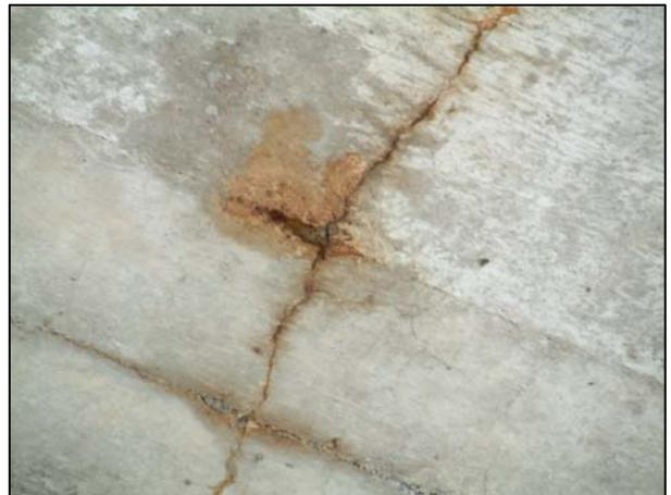
189. Armature rouillée visible au plafond de la partie centrale.
